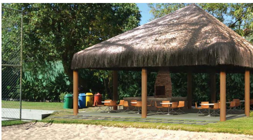
Ampliação da cobertura da churrasqueira junto à quadra do futevôlei
